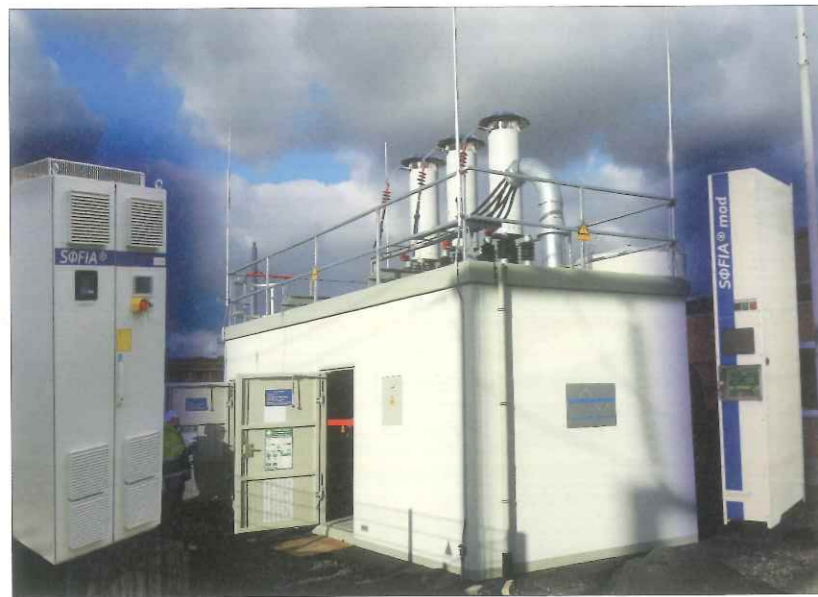
Bild 3: »Sofia«-Filtersystem in verschiedenen Ausführungen. Von links: »Sofia« als Schaltschranksystem/»Sofia«-HV für Hochspannungsanwendungen/»Sofia«-mod als modulares System zur einfachen Integration in Schaltschranke
